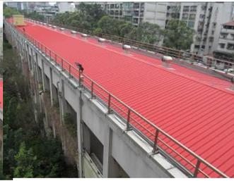
改善老舊校舍漏水施作斜屋頂防漏-和平樓近拍
